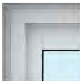
Détail ext: partie supérieure dormant/ouvrant (103mm)
